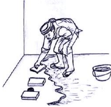
تشطيب بلاطة أرضية المراض بالخرسانة- شكل (2-9)
