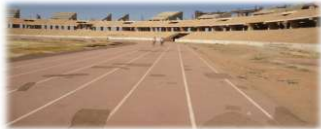
صورة (2-4) توضح العمل المنجز بالمدينة الرياضية(المصدر - الباحث)
