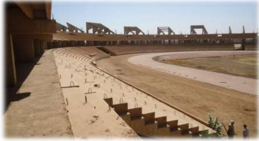
صورة (1-4) توضح العمل المنجز بالمدينة الرياضية(المصدر - الباحث)
