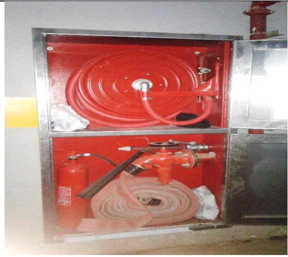
صورة رقم (3-13) توضح خراطيم المياه و نظام الاطفاء بالغاز F200
