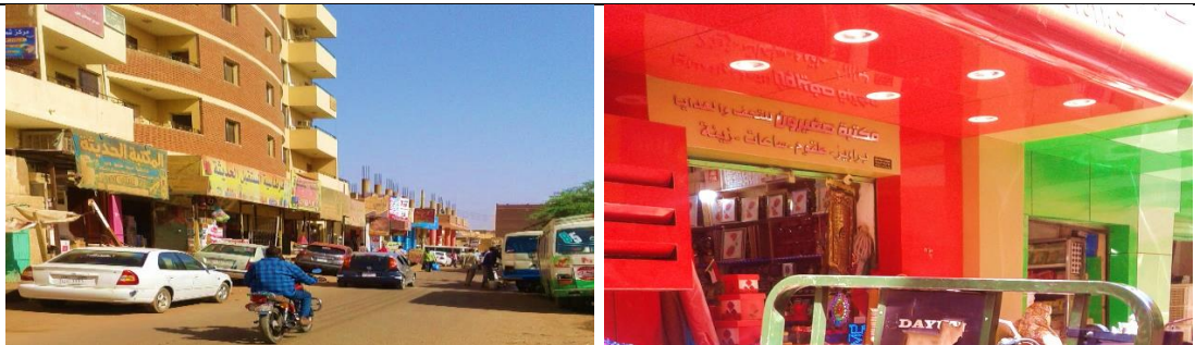
صورة رقم ( 3-24 ) توضح استخدام الكلادن و البياض الاسمني في التشطيبات
