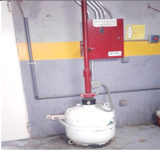
صورة رقم (3-13) توضح خراطيم المياه و نظام الاطفاء بالغاز F200
