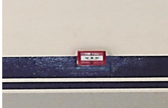
صورة رقم (3-9) توضح نظام الأنداز التلقائي و اليدوي
