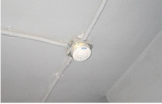
صورة رقم (3-8) توضح حساسات الدخان و الحرارة في المركز التجاري
