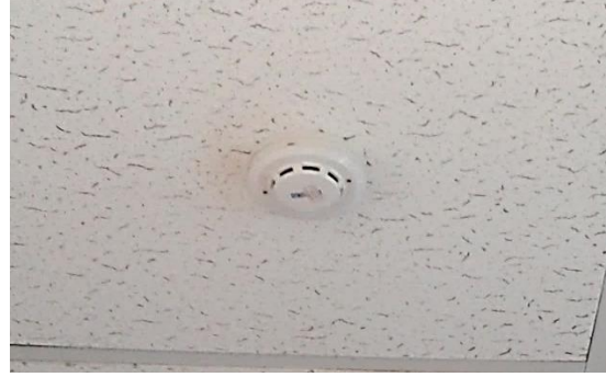
صورة رقم (3-8) توضح حساسات الدخان و الحرارة في المركز التجاري
