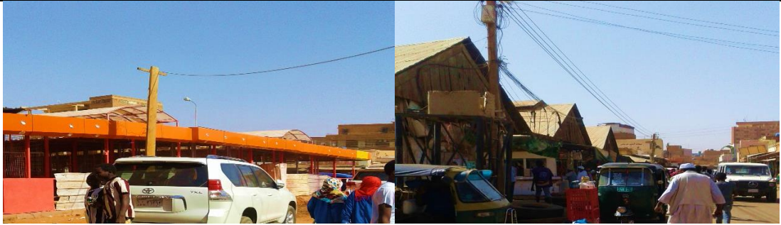
صورة رقم ( 3-22 ) توضح المباني المنشئة من الحديد و الجمولونات
