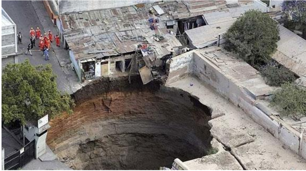
شكل رقم (4-1) انهيار بسبب ضعف التربة، المصدر: مختار عبد الله مختار 2014، أسباب انهيار المباني وطرق معالجتها، دراسة بكالوريوس، جامعة سنار.
