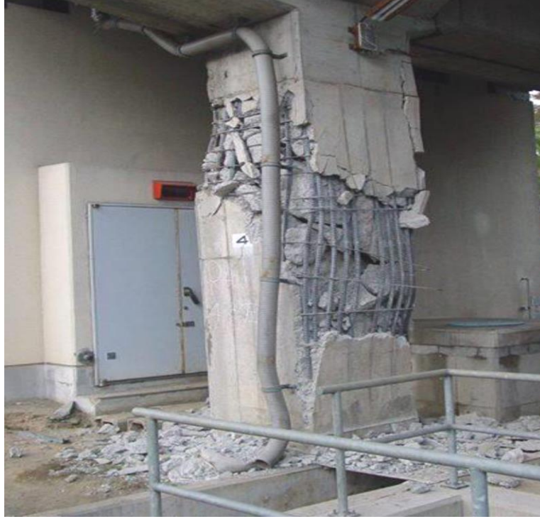
شكل رقم (3-1) سؤ الخرسانة وزيادة التحميل،المصدر الباحث.
