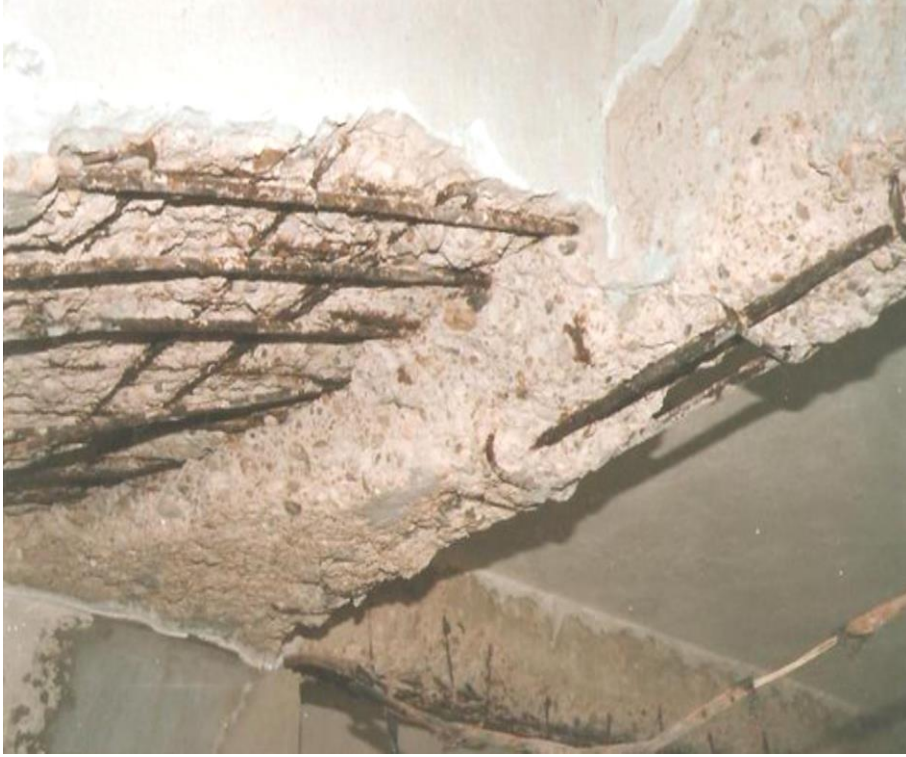
شكل رقم (4-13) تشققات خرسانية بسبب الرطوبة ورداءة المواد المستخدمة، المصدر الباحث
