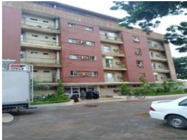
شكل (4-6) صورة لمبنى وزارة البيئة والموارد الطبيعية والتنمية العمرانية
