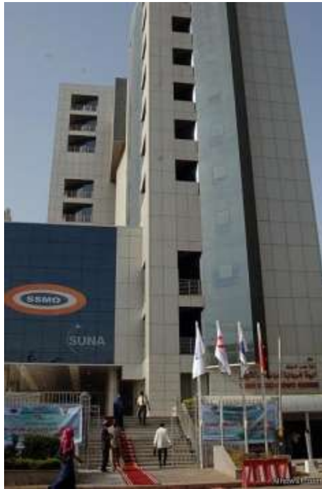
شكل (4-4) صورة لمبنى الهيئة السودانية للمواصفات والمقاييس
