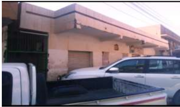
شكل (4-8) صورة لمبنى شركة شبكية للإنتاج الزراعي
