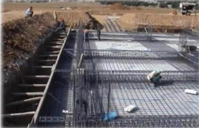
وهي ارضية البدروم الخرسانية التي تكون شديدة التسليح ومتصلة بحوائط خرسانية مع حدود المبنى حيث أن النظرية الإنشائية لهذا النوع من الأساسات تكمن في عمل شبكة خرسانية أسفل المبنى تقوم بشد التسليح وربطه ببعضه البعض حتى يعطي تأسيسا متينا .
