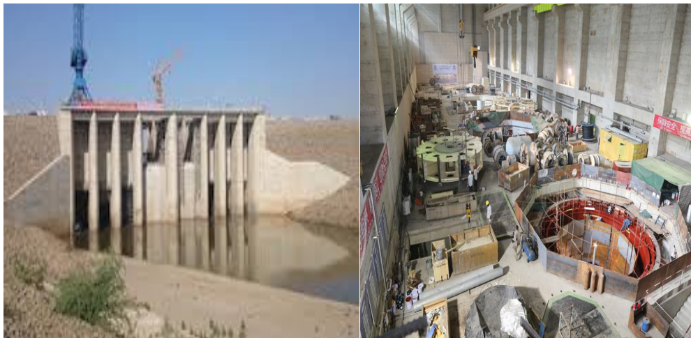
شكل 3-3 محطة التوليد و سد المفيض على نهر عطبرة اثناء التشيد
