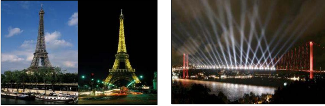
شكل (3-35) يوضح الإضاءة الخارجية بنوعها الخدمية التزيينية في الصورة الأولى كبري البسفور في تركيا وفي الصورة الثانية برج إيفل (kocaoglu، 2011)
