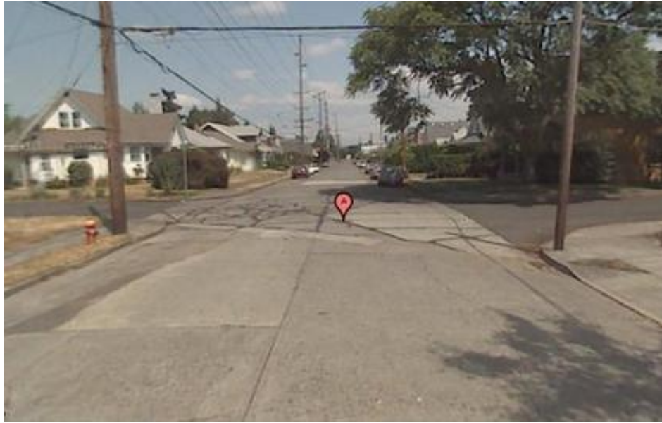
شكل رقم (2-23): الموقع المباشر قبل بدء عملية الإصلاح. المصدر : ( http://cityrepair.org/about/how-to/place ، 2017 )
