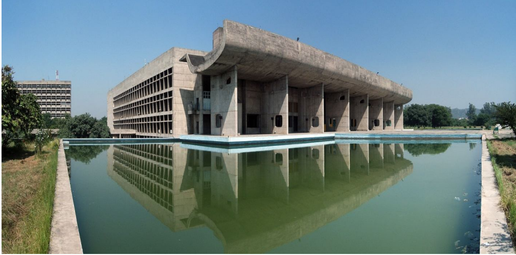
صورة (2-17) توضح مبنى قصر الاجتماعات في شانديغار - المصدر - مرجع [30]
