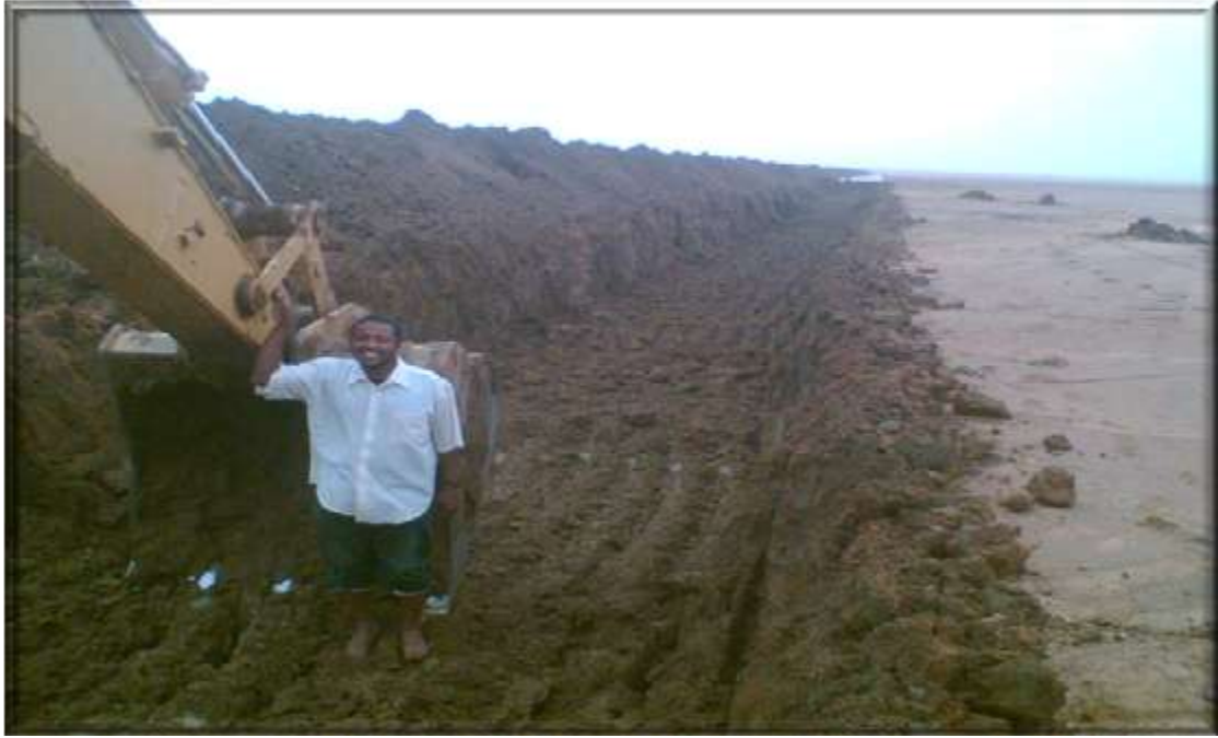
صورة رقم (3-15) توضح حفر المصارف
