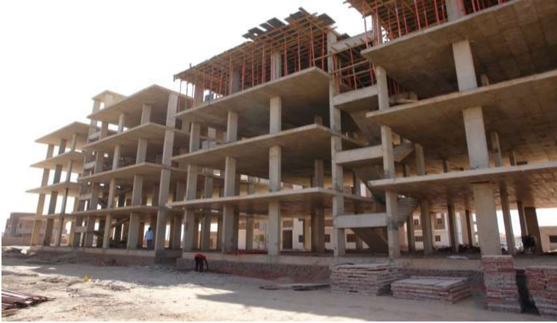
صورة رقم (3-16) توضح أعمال البناء
