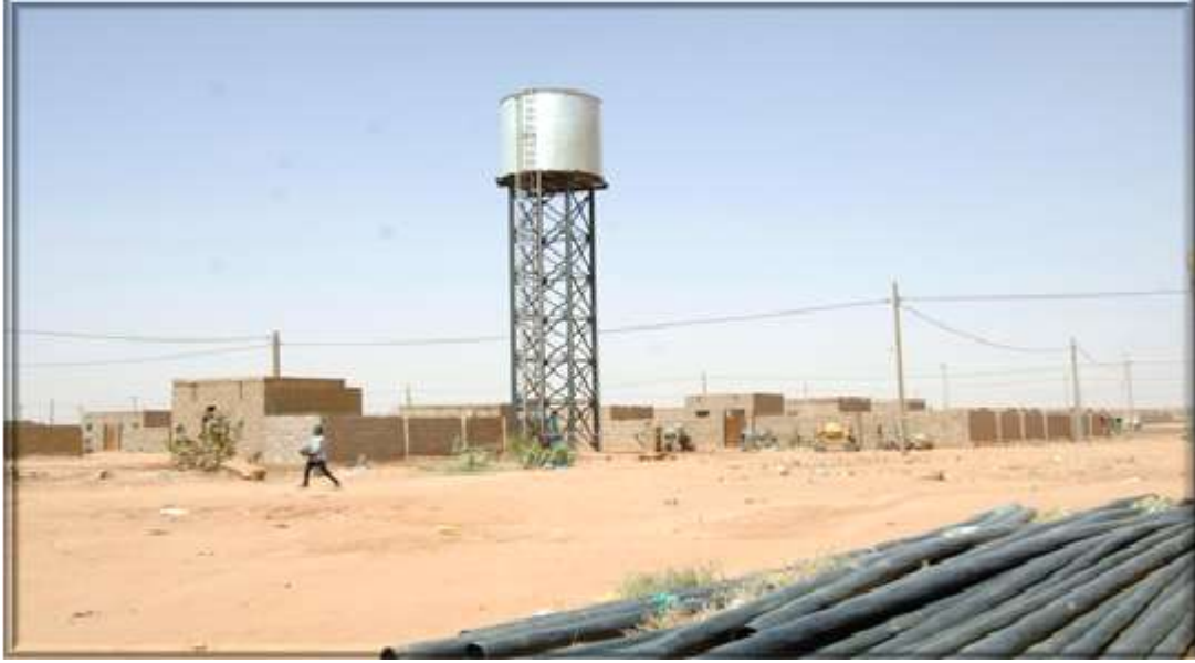
صورة رقم (3-13) توضح صهاريج المياه
