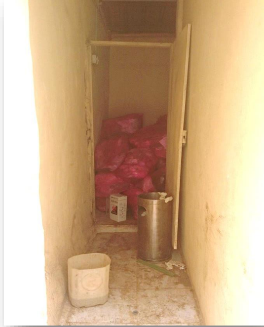
صورة ( 4 - 16 ) : غرفة تخزين النفايات المؤقت ( زيارة ميدانية 2017م )
