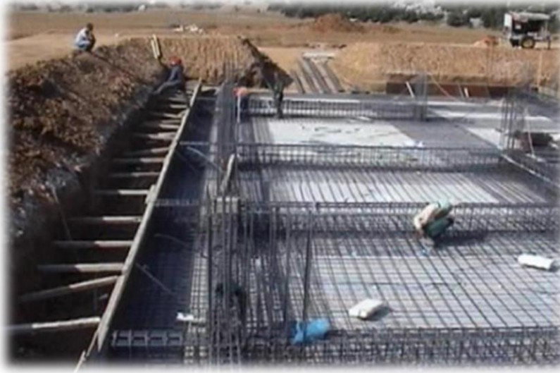
صورة رقم 35 توضح أساس الحصيصة أثناء الإنشاء
