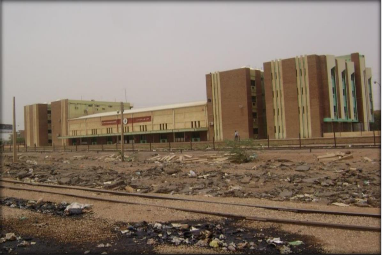
صوره رقم (43) صورة للمحطة من الناحية الشمالية الشرقية ( توضح كتلة المبنى وكيفية ربطها بخطوط المحطة )
