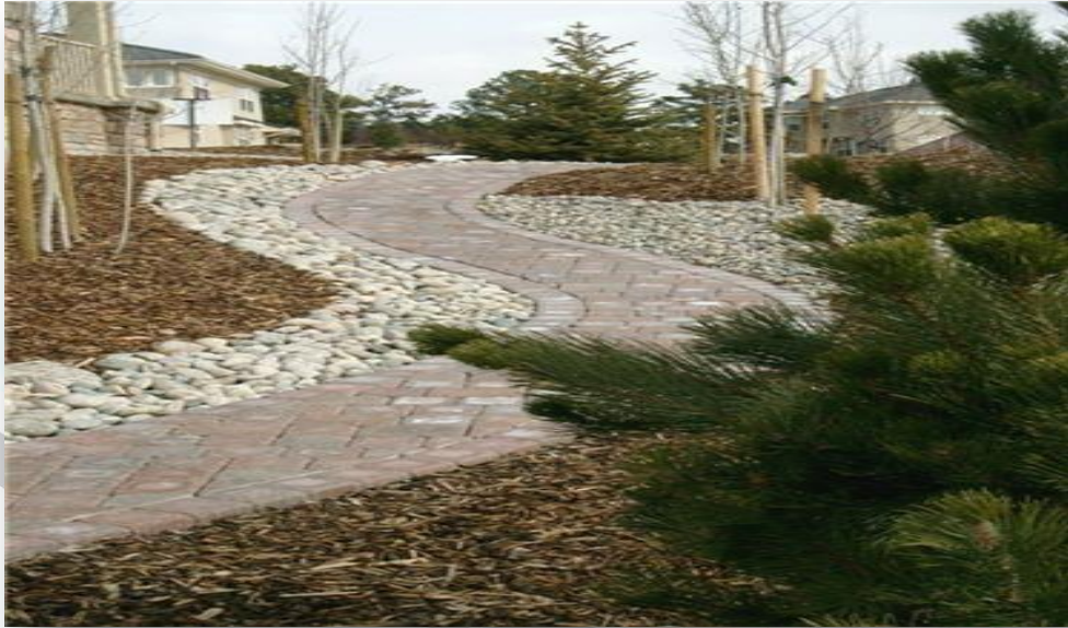
صورة(5-6)توضح شكل التبليط من الحجر الطبيعي بطريقة الانتر لوك .
