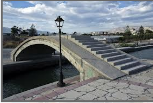
صورة (5-7) توضح نموذج لاجد الجسور الخرسانية فوق المجاري.
