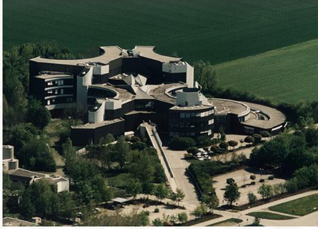
المبنى الرئيسي شكل (9-2)
