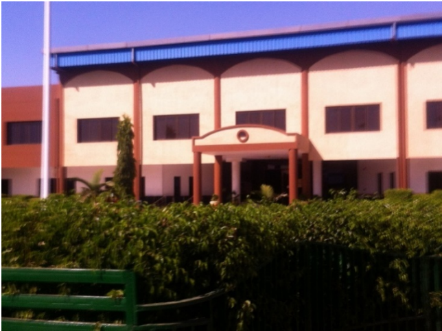
صورة 2-2 الواجهة الرئيسية للنادي
