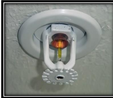
صورة(5-34) توضح رشاشات المياه
