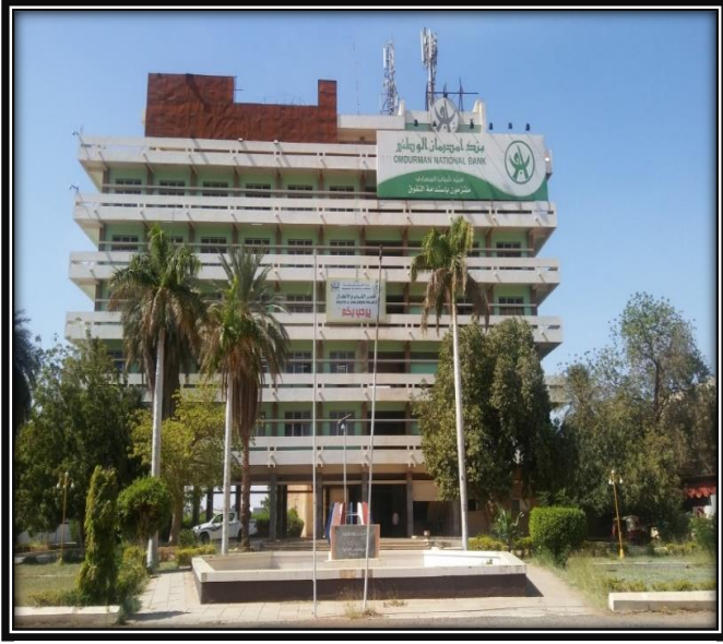
صورة (2-1) توضح واجهة المبنى.
