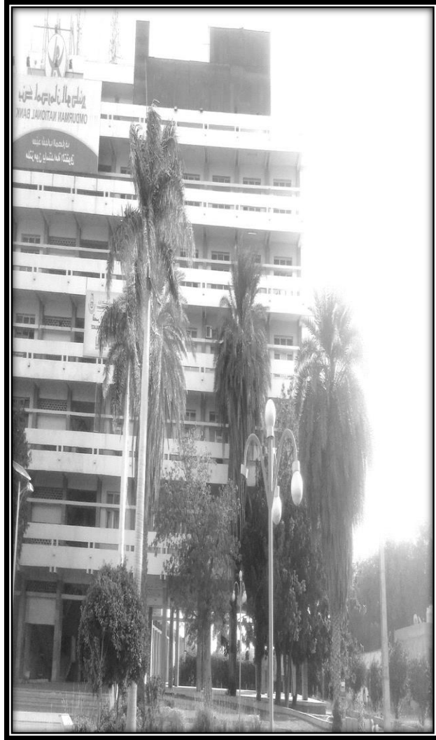
صورة (2-5) توضح الواجهة الرئيسية للمبنى
