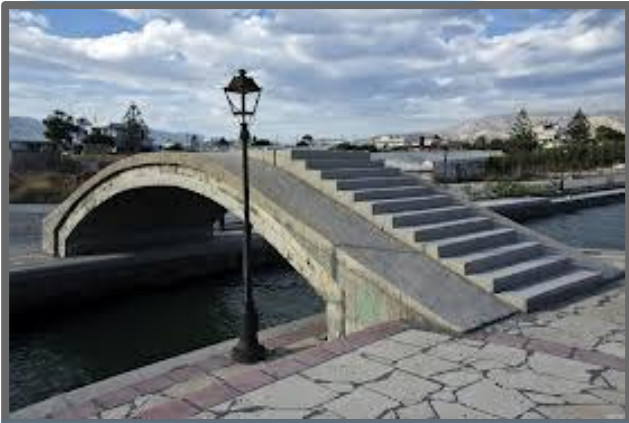
صورة توضح نموذج لاجد الجسور الخرسانية فوق المجاري.
