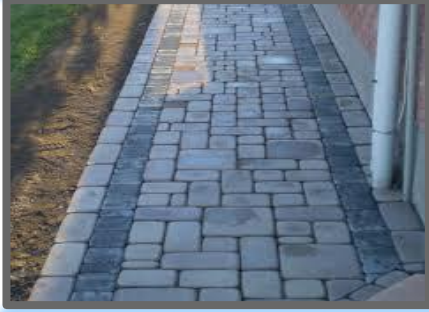
صورة توضح شكل التبليط من الحجر الطبيعي بطريقة الانتر لوك .
