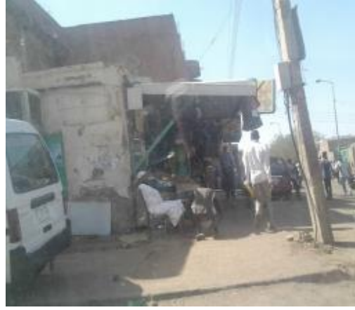
صورة رقم (3-22) توضح عدم ترميم المباني القديمة بمنطقة الدراسة - المصدر: الباحث
