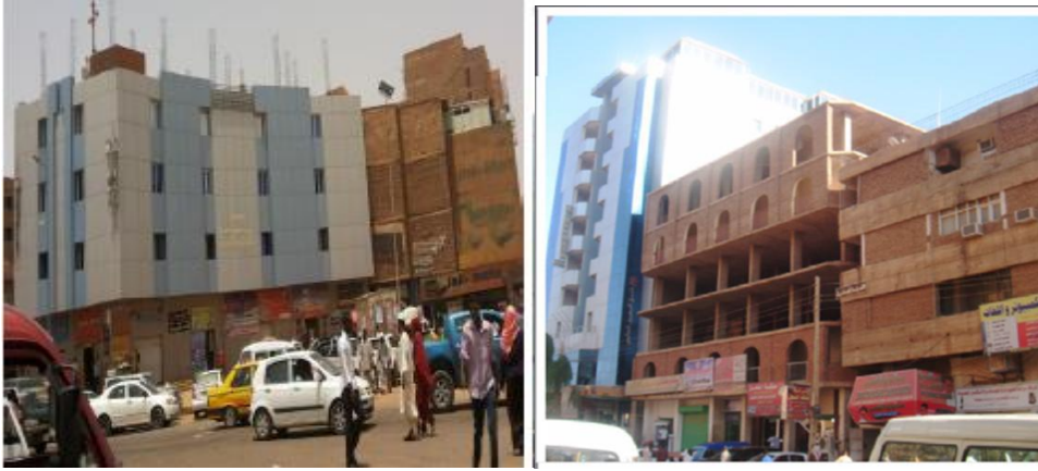
صورة رقم (3-23) توضح التناقض الذي يسببه تجليد المباني القديمة بالألومنيوم - المصدر: الباحث
