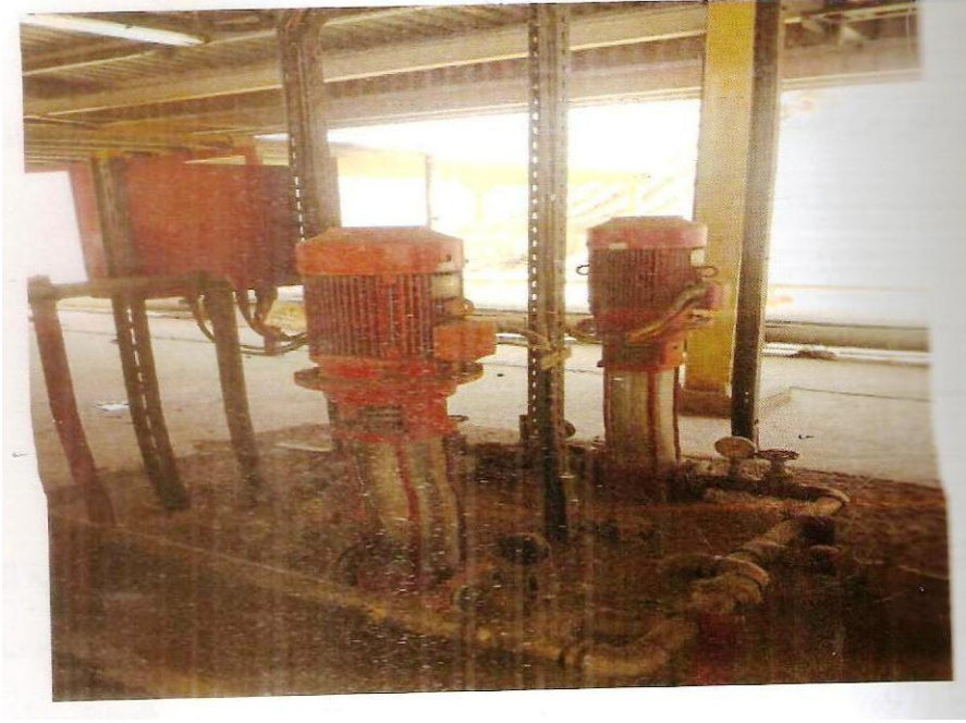
شكل (3-4) يوضح المضخات المستخدمة في نظام الرغوة
