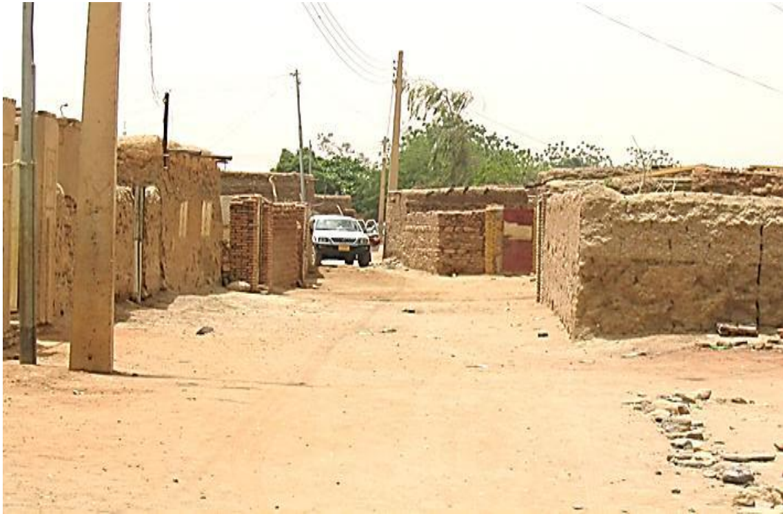
صورة رقم (6/2) توضح منطقة سكن عشوائي
