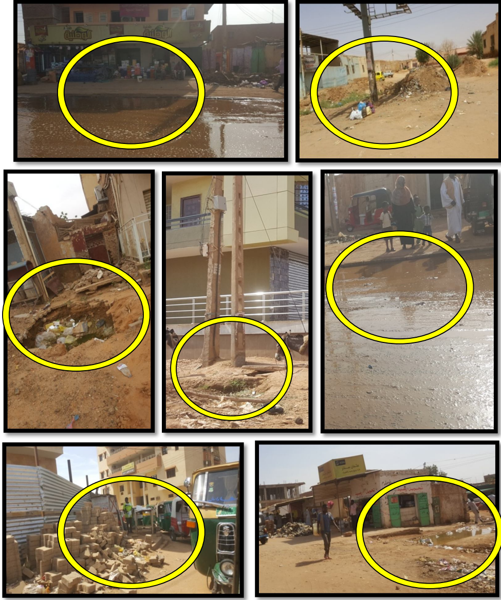
صور (4-19) توضح المشاكل الخدمية المصدر (الباحثة)
