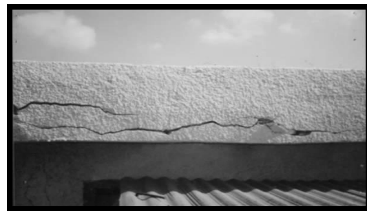
شكل (7-2) حدوث شروخ في الكمرة نتيجة نقص حديد التسليح
