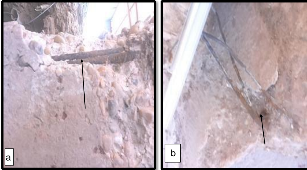
شكل(3-11) صدأ حديد التسليح التربة تحت التأسيس
