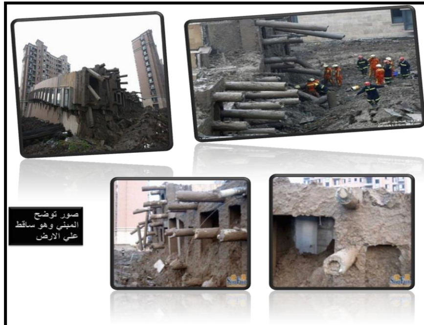
شكل (3-5) اساسات المبنى
