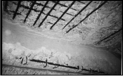
شكل ( 2-10 ) شروخ وسقوط الغطاء الخرساني ناتج عن صدأ حديد التسليح نتيجة العوامل الجوية والابخرة
