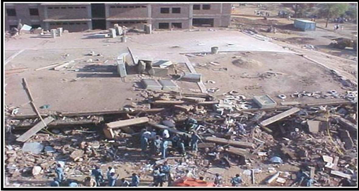
( شكل 3-13 ) مبنى المعامل بمستشفى الرباط الوطني
