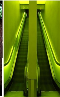
(أ) السلم الكهربائي لمدخل البهو
