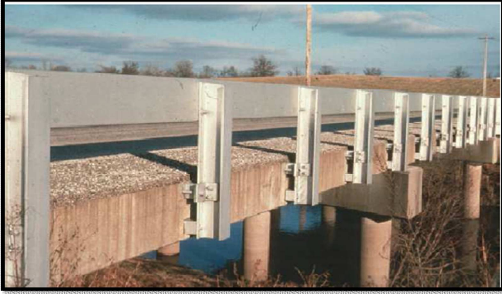
شكل (2-3) أء جسر البلاط مسبقة الصنع مسبقة الإءءاء ( FHWA, bridges inspection manual, 2006)
