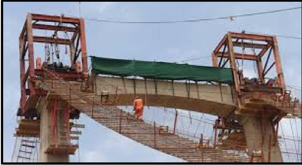
شكل (3-17) جسر توتي اثناء التشييد
