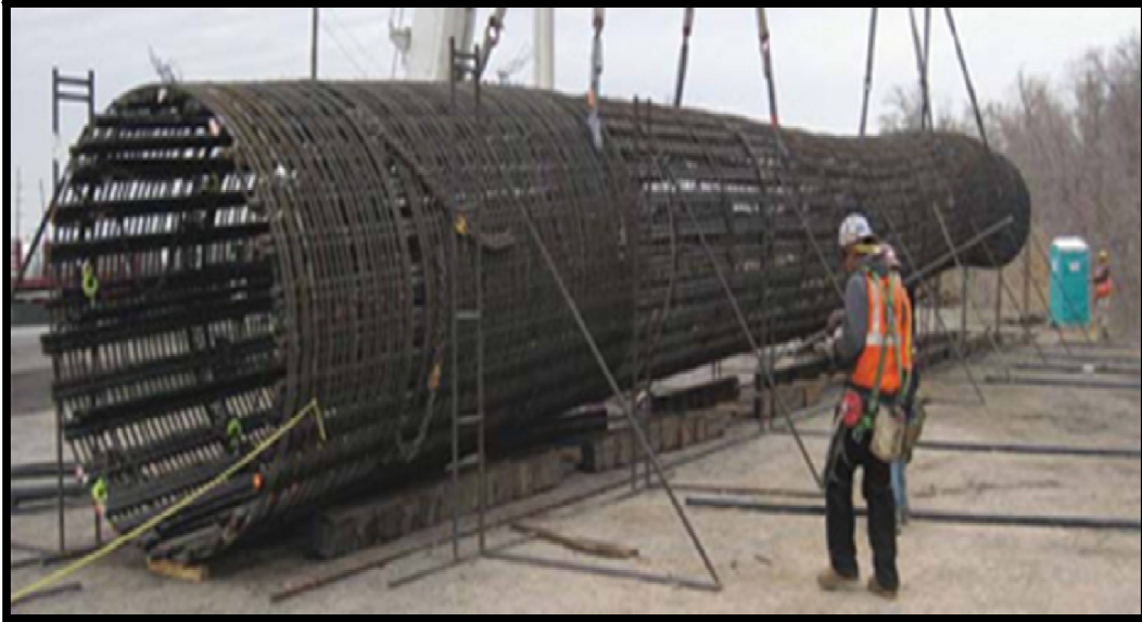
شكل (3-4) حديد تسليح أعمدة جسر سوبا
