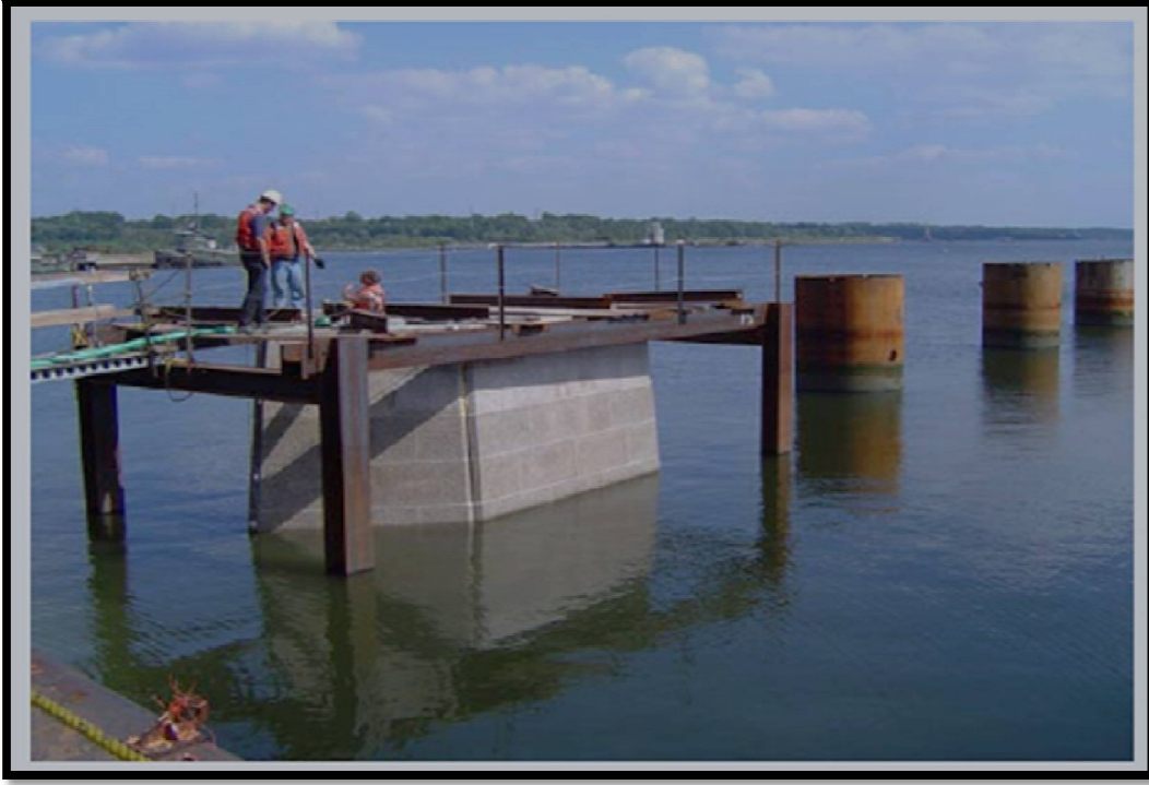
شكل (3-3) جسر سوبا عملية تفريغ القاعدة
