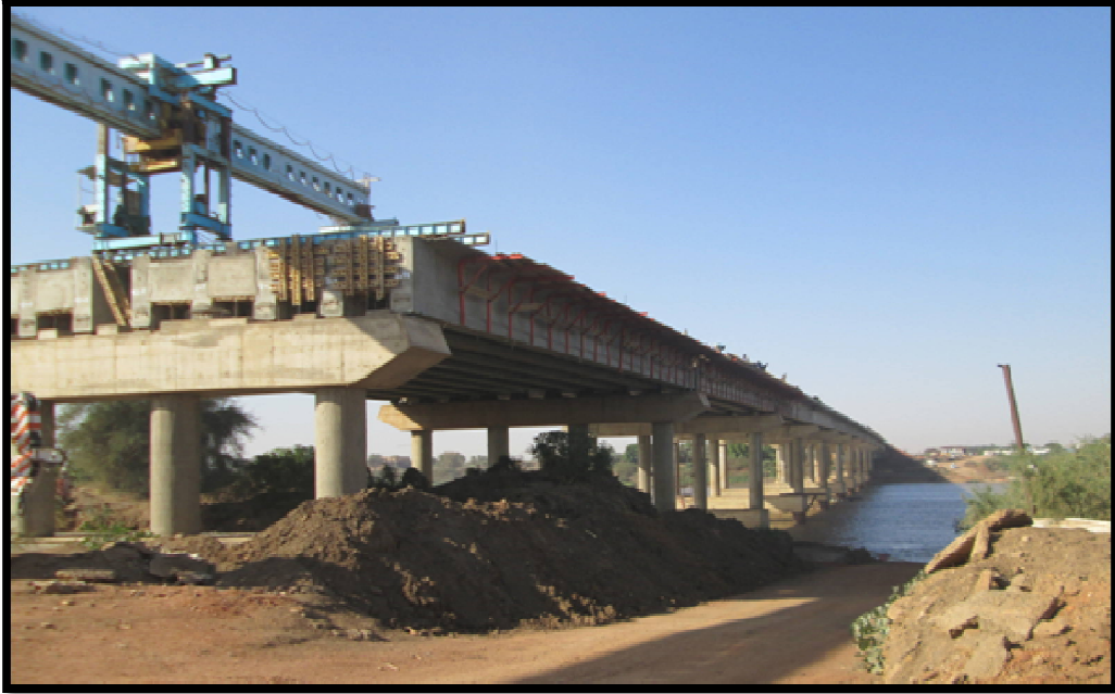
شكل (2-3) جسر سوبا اثناء تركيب العارضات
