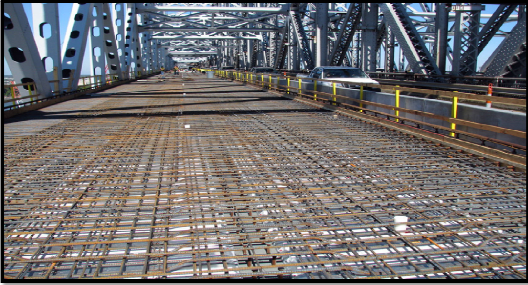
شكل (3-8) صب بلاطة جسر سوبا
