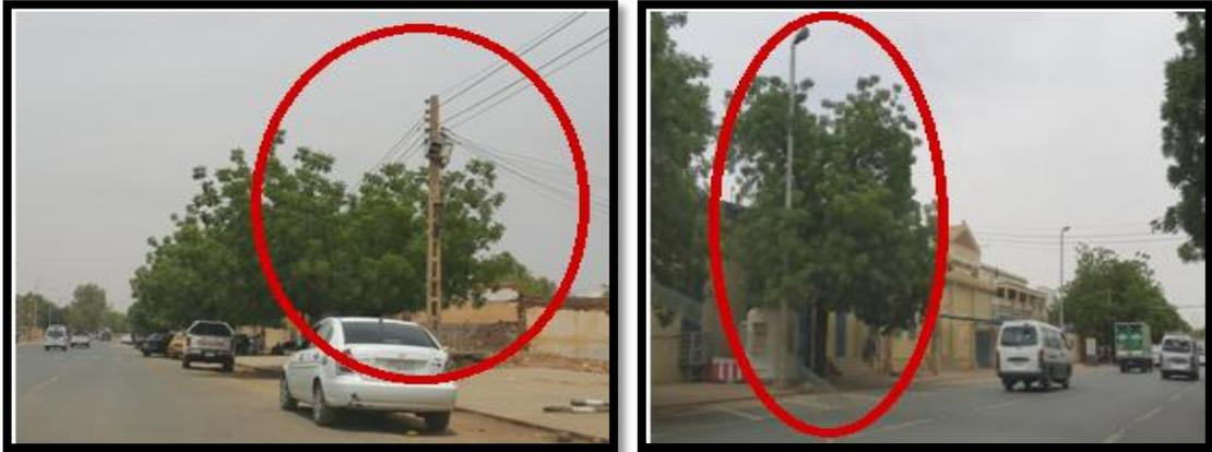
شكل (4-64) صور توضح التداخل بين الأشجار واعمدة واسلاك الكهرباء.
