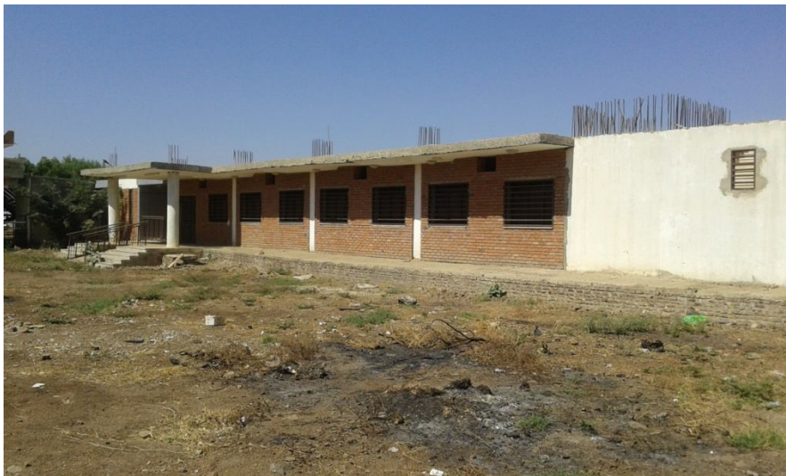
صوره (5-3): مبني مركز القلب تحت التشييد
