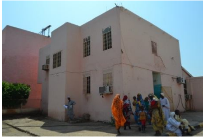
صورة (44-4): مبنى حوادث الأطفال
