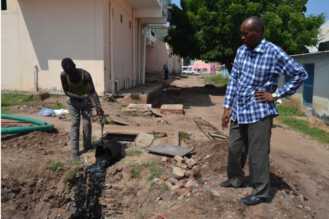
(80-4):التفريغ اليدوي لحوض التحليل الممتلئ في حفرة مجاورة للحوض الشرقي
