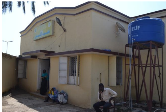
صورة (19-4): مبنى عيادة الأسنان
