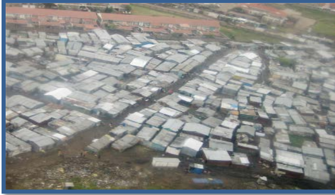
صوره (خ) توضح استخدام الصفيح في المباني
