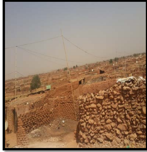
صورة (٣-١٨) منطقة توفر الكهرباء
