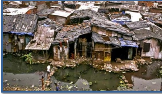
صوره (ح) توضح استخدام الخشب والأقمشه في المباني
