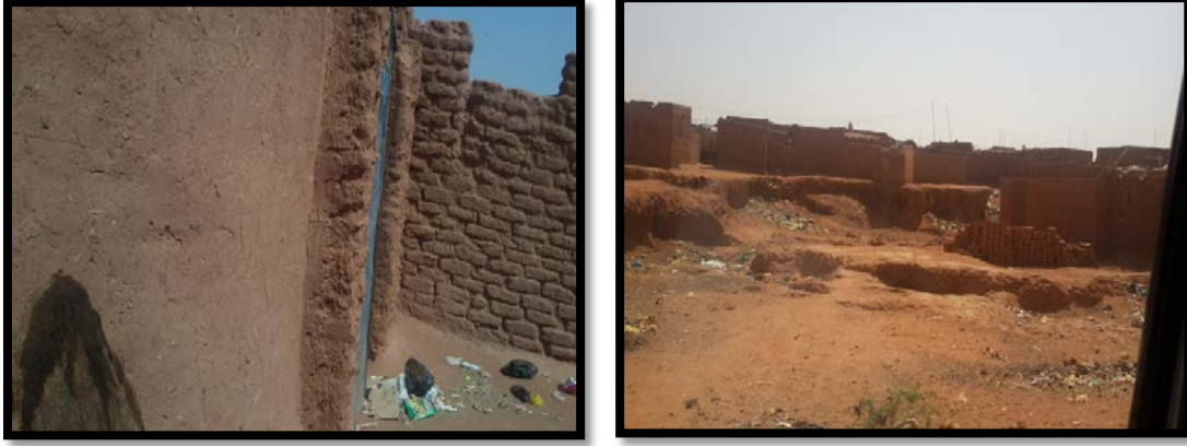
صوره (س) توضح التنوع في مواد البناء المستخدمه
