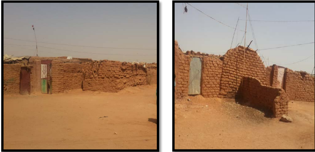
صوره (٣-٢٥) توضح عدم وجود الألوان في المباني
