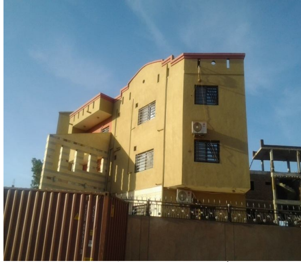
صورة رقم (11-3) توضح أماكن مكيفات الهواء في واجهات المباني بمدينة الخرطوم المصدر: الباحث
