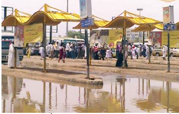
صورة رقم (28-3) توضح سوء تصريف مياه الأمطار بميدان جاكسون
