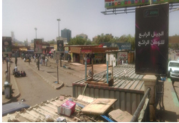
صورة رقم (3-32) توضح الإستغلال الخاطئ لأسطح المباني بميدان جاكسون المصدر:الباحث
