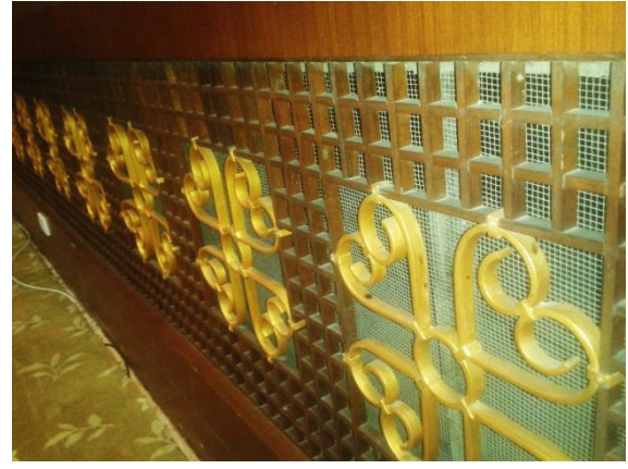
صورة رقم (4-17) تشطيب الحوائط الجانبية الواح من الشبك مغلف لمادة ليفية ماصة للصوت
