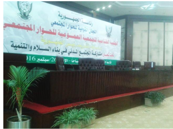
صورة رقم (4-19) شكل المنصة الامامية ويبدو توع تشطيبها بالخشب العرضى كفراغات رنانة ماصة للصوت
