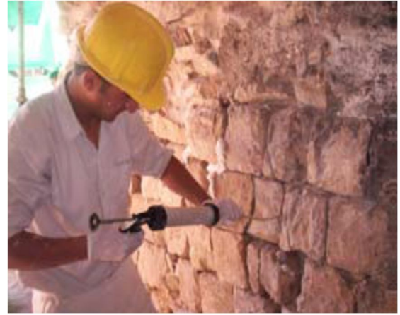
صورة حقن فراغات الحجر بالمادة الغرائية
