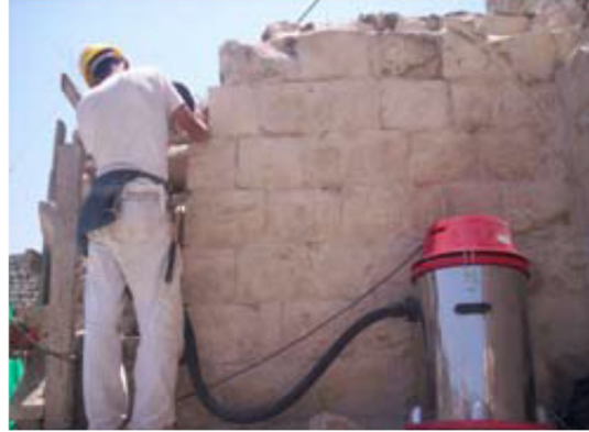
صورتوضح: نفخ الهواء المضغوط داخل الفراغ
