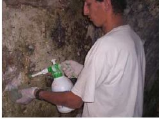
صورة حقن فراغات الحجر بالماء.
