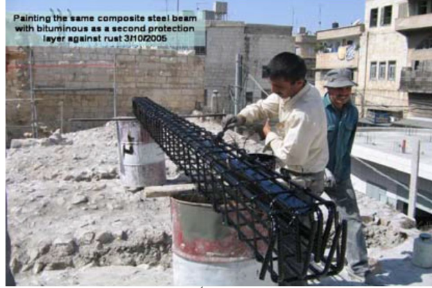
التوثيق الإنشائي أثناء الترميم
