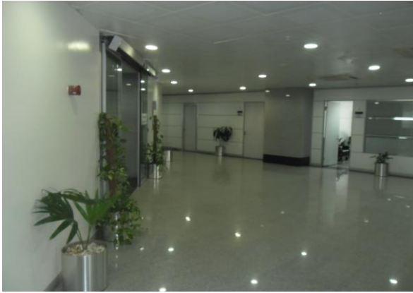
صورة (4-43) إضاءة المساحات المخصصة كاستقبال للطابق بواسطة وحدات الـ Down Lights الاقتصادية ويظهر نصيب هذه المساحات الخافت من الإضاءة بالمقارنة مع نظيراتها المكاتب
