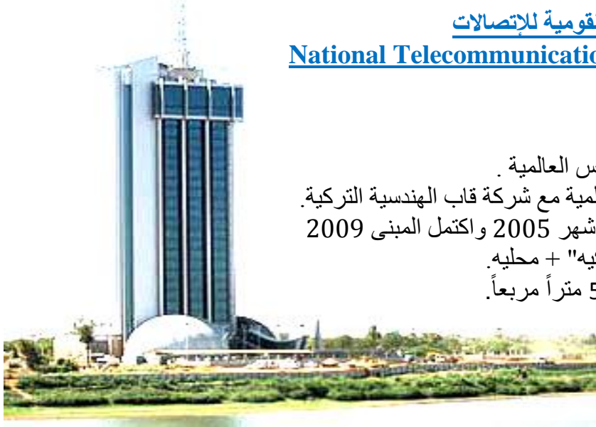
صورة (4-39) واجهة إطلالة مقر مبنى هيئة الاتصالات
