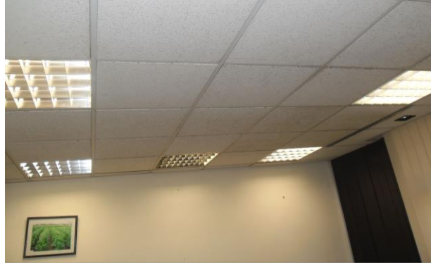
صورة (4-18) وحدات إضاءة المكاتب المغلقة 60*60 Florescent Ceiling ذات اللون Warm white
