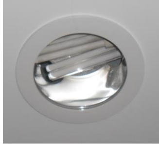
صورة (4-31) وحدات Down Lights الاقتصادية موزعة باللون Warm white على سقف جبسي ديكوري لإضاءة منطقة الإستقبال بالطابق وكذلك الممرات الرابطة بين فراغات الطابق بالإضافة لوحدات إضاءة الطوارئ المنتشرة في السقف المستعار .
