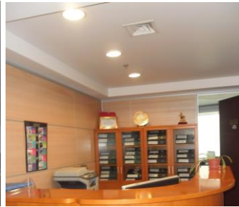
صورة (4-31) وحدات Down Lights الاقتصادية موزعة باللون Warm white على سقف جبسي ديكوري لإضاءة منطقة الإستقبال بالطابق وكذلك الممرات الرابطة بين فراغات الطابق بالإضافة لوحدات إضاءة الطوارئ المنتشرة في السقف المستعار .
