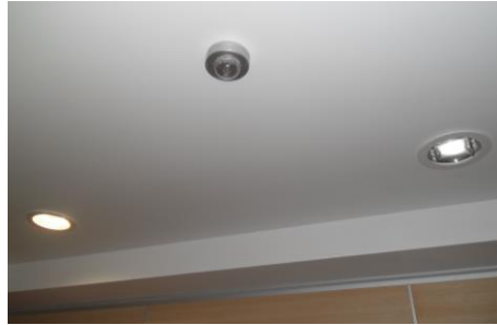
صورة (4-31) وحدات Down Lights الاقتصادية موزعة باللون Warm white على سقف جبسي ديكوري لإضاءة منطقة الإستقبال بالطابق وكذلك الممرات الرابطة بين فراغات الطابق بالإضافة لوحدات إضاءة الطوارئ المنتشرة في السقف المستعار .
