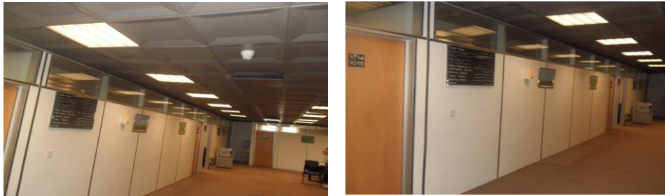
صورة (4-17) وحدات إضاءة الممرات الأساسية Down lights ذات اللون Warm white
