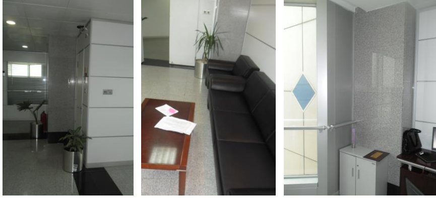
صورة (4-50) تنوع تشطيبات الفراغات الداخلية للمكاتب - من رخام أرضيات وجلد للمفروشات وألمونيوم للابواب والفواصل وخشب للطاولات
