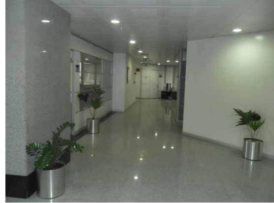
صورة (4-44) إضاءة الممرات الرابطة بين المكاتب المغلقة بوحدات الـ Down Light ذات لون الإضاءة الأبيض
