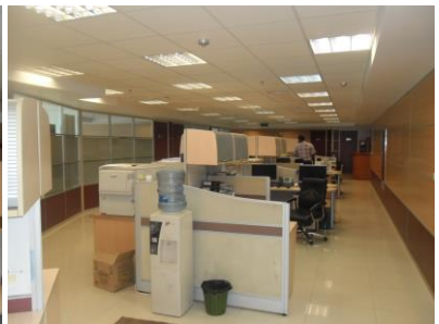
صورة (4-32) وحدات إضاءة منطقة المكاتب الوسطية المفتوحة 60*60 Florescent Ceiling بعدد 25 وحدة تزيد وتنقص حسب مساحة المسقط غاطسة في سقف مستعار باللونين Warm White & Cool White
