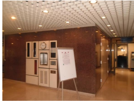
صورة (4-20) إضاءة الاستقبال المؤدي لمساعد الطوابق ويربط بالبوابة الخارجية عامة بوحدات Down lights موزعة بانتظام على سقف ديكوري مستعار مخرم Perforated والألوان الدافئة تغلب على المكان
