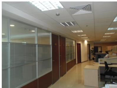
صورة (4-32) وحدات إضاءة منطقة المكاتب الوسطية المفتوحة 60*60 Florescent Ceiling بعدد 25 وحدة تزيد وتنقص حسب مساحة المسقط غاطسة في سقف مستعار باللونين Warm White & Cool White
