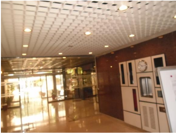
صورة (4-20) إضاءة الاستقبال المؤدي لمساعد الطوابق ويربط بالبوابة الخارجية عامة بوحدات Down lights موزعة بانتظام على سقف ديكوري مستعار مخرم Perforated والألوان الدافئة تغلب على المكان
