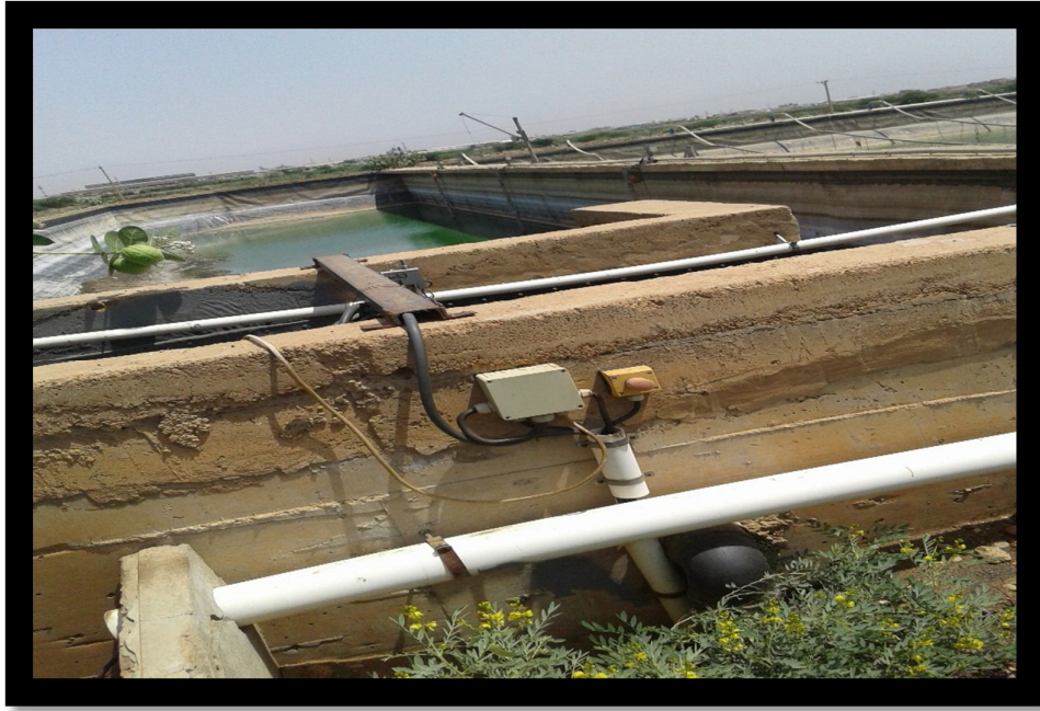
صورة توضح سوء تنفيذ الخرسانة
