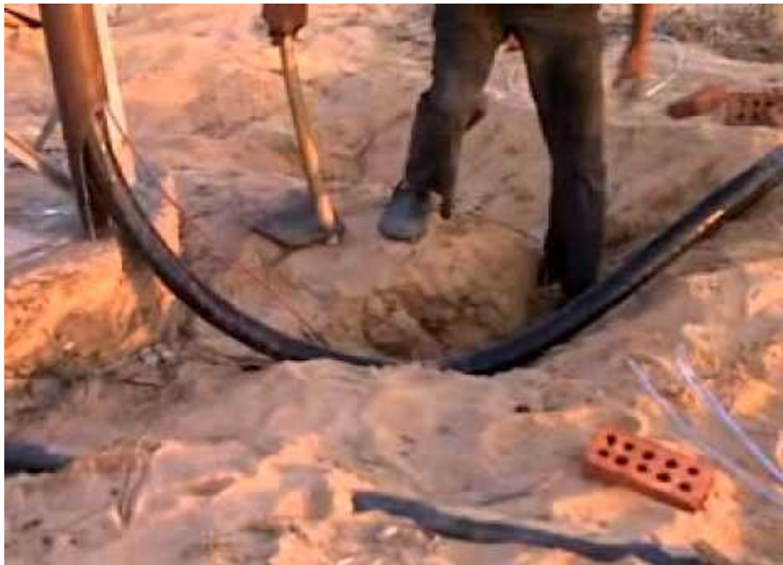
شكل رقم (6) يوضح تحديد العطل في الكابل
