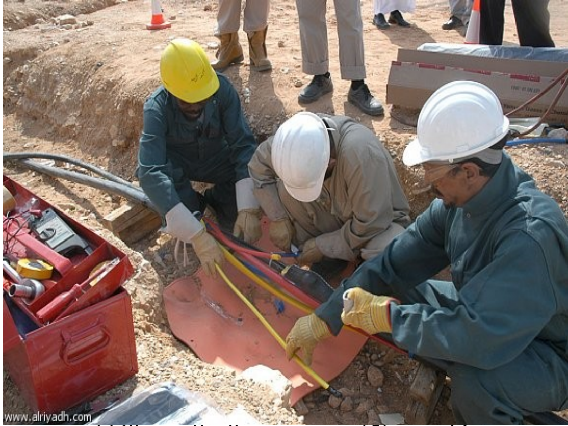
شكل رقم (6) يوضح تحديد العطل في الكابل
