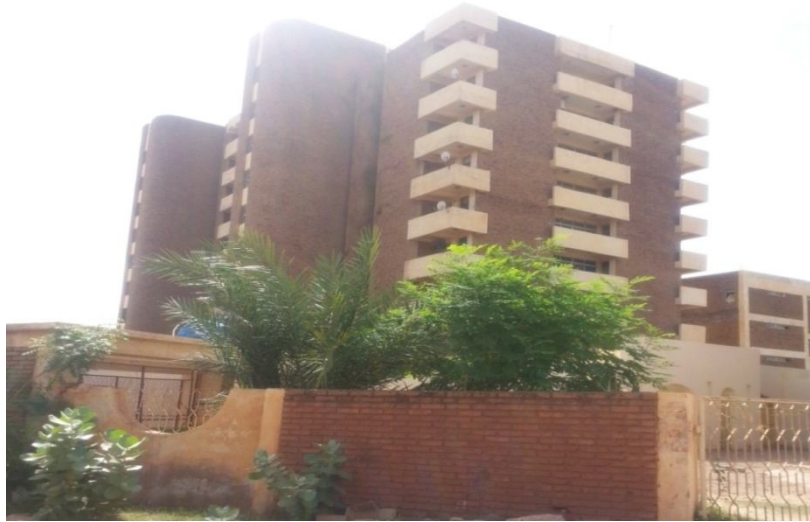
الشكل رقم (3-10) يوضح الواجهة الشرقية للمبنى . المصدر : الباحث
