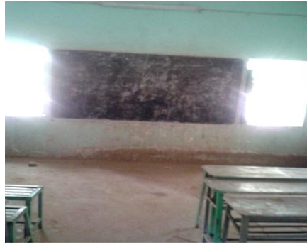
صور (4-41) توضح وضعية النوافذ الخاطئة
