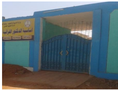
صورة (4-36) توضح مدخل المدرسة
