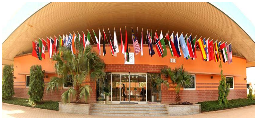
صورة (2-4) توضح مدخل المدرسة
