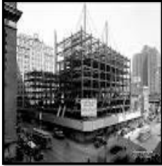
شكل(4-36) مبنى كرايسلر اثناء التشييد
