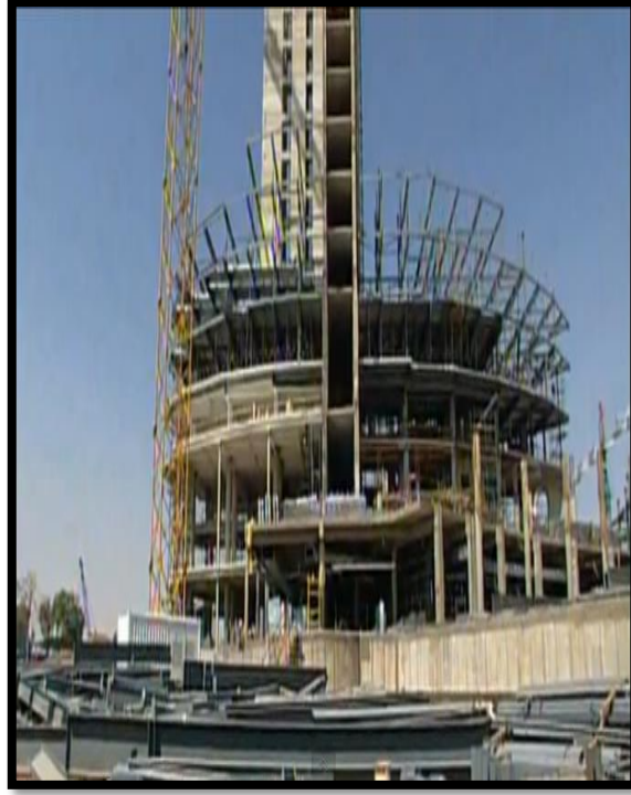
شكل (4-43) صب flat slab
