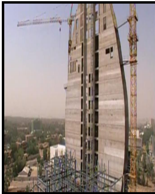
شكل (4-42) نواه فندق كورنثيا الخرسانيه
