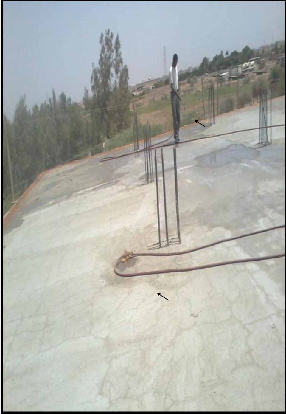
شكل (٢ - ٦١) ظهور التشققات علي السطح
