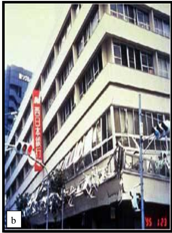
شكل (٢ - ١٣) انهيار بسبب طابق رخو
