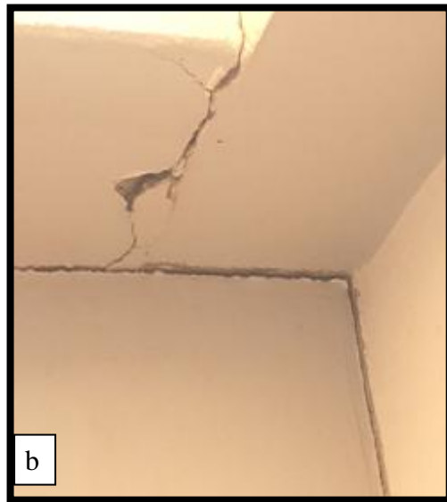
شكل ( ٢-٣ ) ظهور التصدعات في بلاطة السقف
