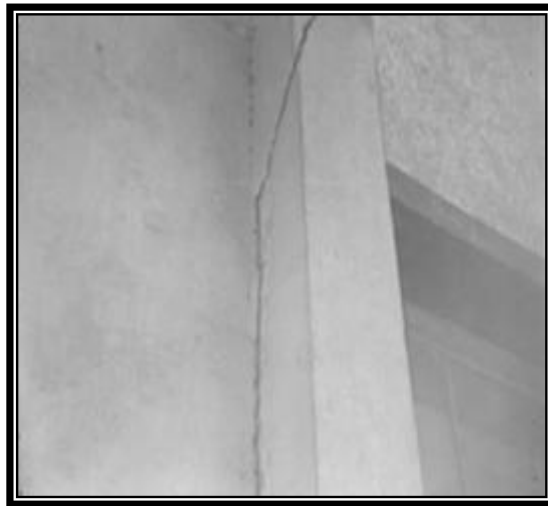
شكل (٤٥ - ٢) شروخ ناتجة عن صدأ حديد التسليح نتيجة العوامل الجوية والأبخرة
