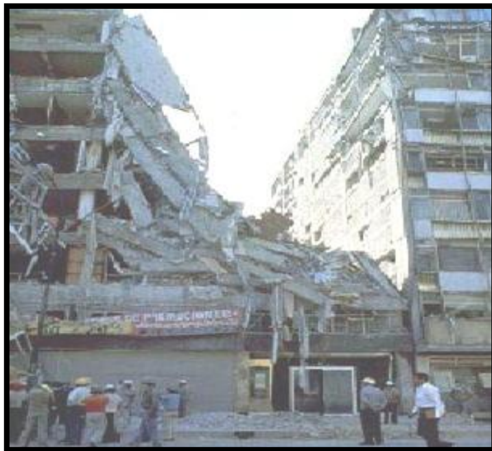
شكل (٢ - ١٤) تلاصق المباني - عدم وجود فاصل زلزالي
