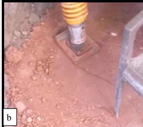
شكل (٨ - ٣) ماكينة الدمك علي الردميه الخرسانيه
