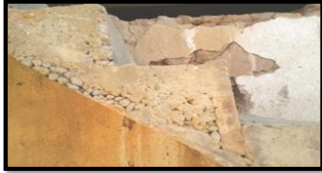
شكل ( ٢- ٥٦ ) تآكل الخرسانه
