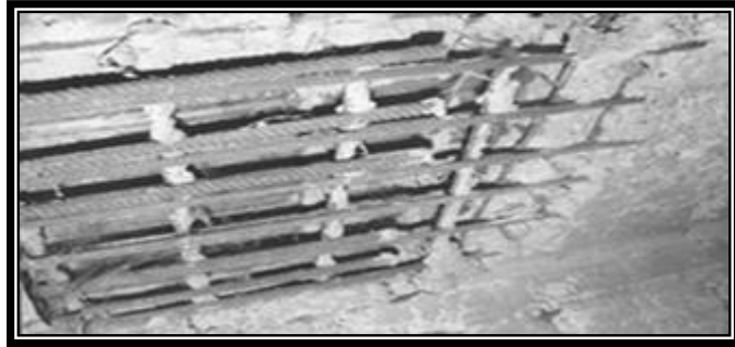
شكل ( ٣٨ - ٢ ) تعشيش الخرسانة في البلاطة
