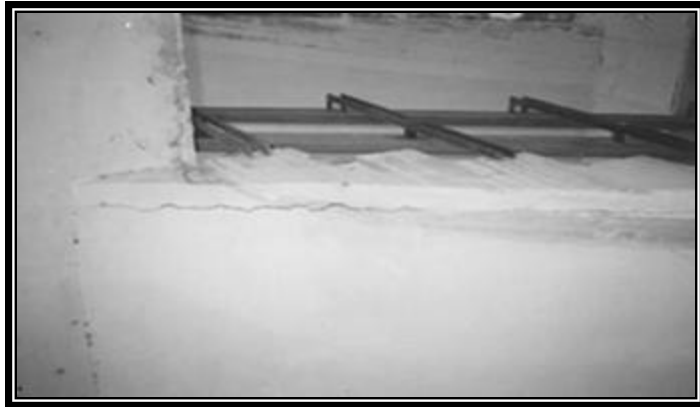
شكل ( ٤٠ - ٢ ) شروخ في بلاطة السلم لسوء التنفيذ
