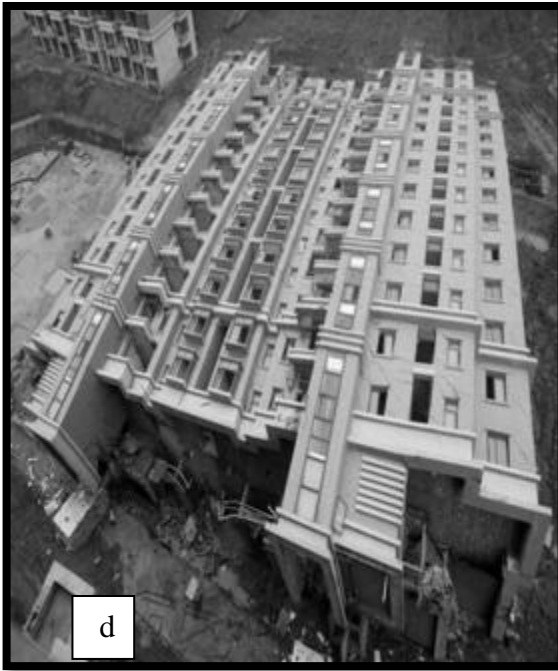
شكل (٢ - ٤) d - e - انهيار المبنى في مدينة شنغهاي
