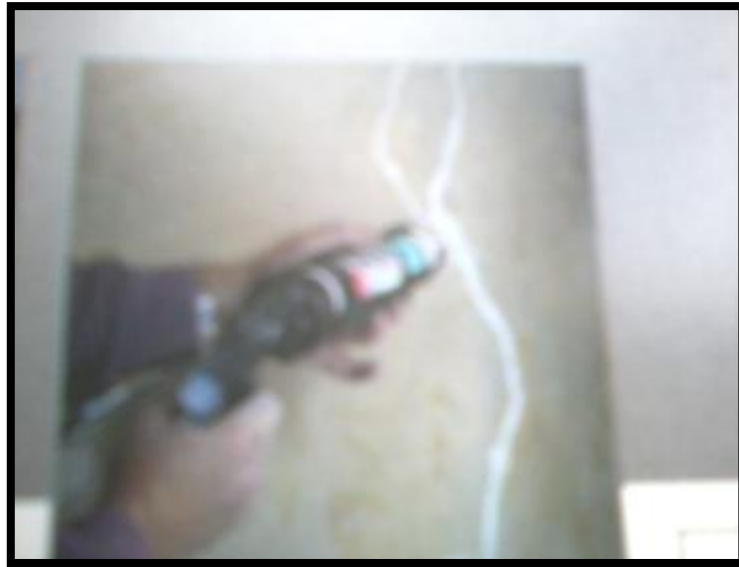
شكل (٢- ٥٣) طريقة الحقن
