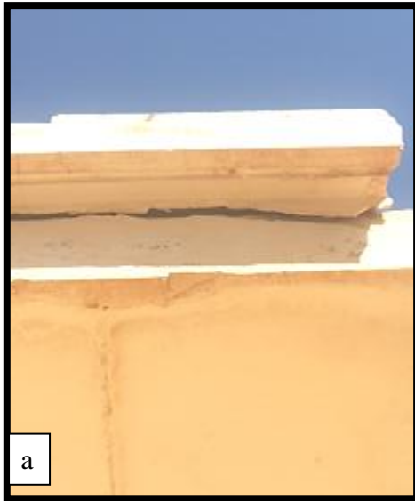
شكل ( ٢-٣ ) ظهور التصدعات في بلاطة السقف
