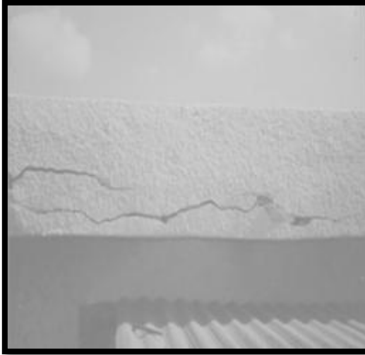
شكل ( ٢ - ٢٧ ) شروخ ناتجة عن صدأ في حديد التسليح
