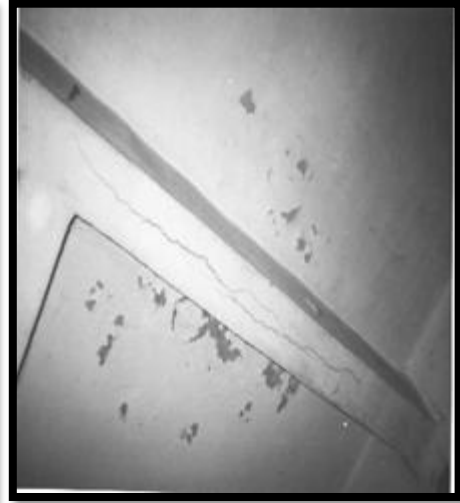
شكل ( ٢ - ٢٧ ) شروخ ناتجة عن صدأ في حديد التسليح
