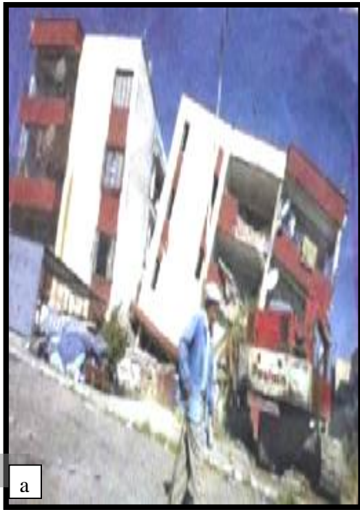
شكل (٢ - ١٣) انهيار بسبب طابق رخو
