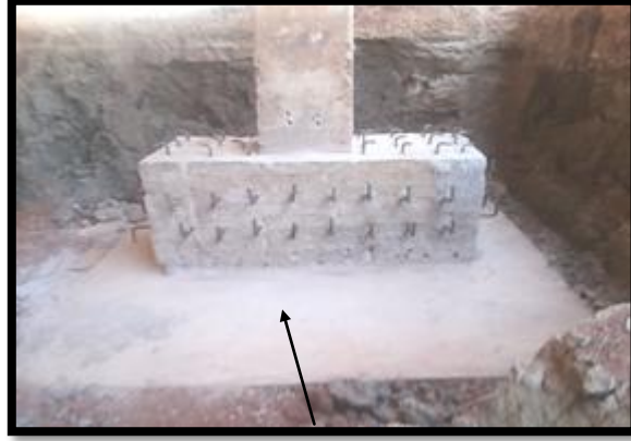
شكل (٣- ٩) صب الخرسانه لحماية القواعد
