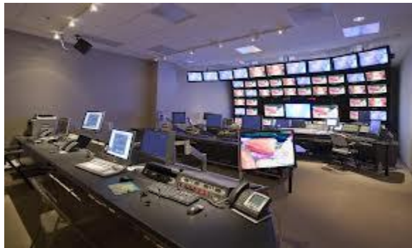
شكل رقم (6) يوضح غرفة مراقبة الفيديو
