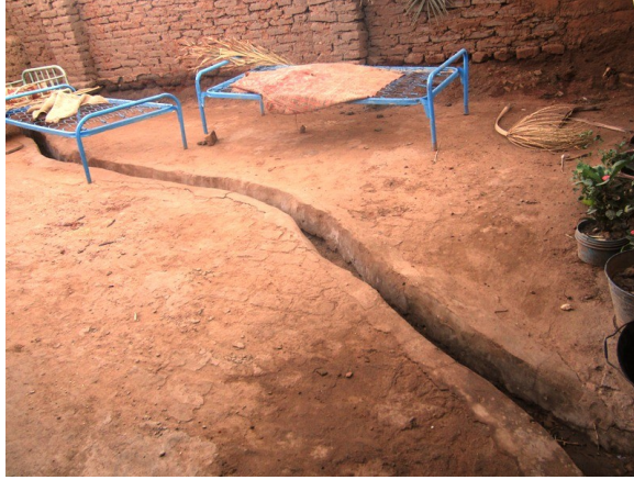
شكل (4-20) يوضح مجرى تصريف مياه الامطار
