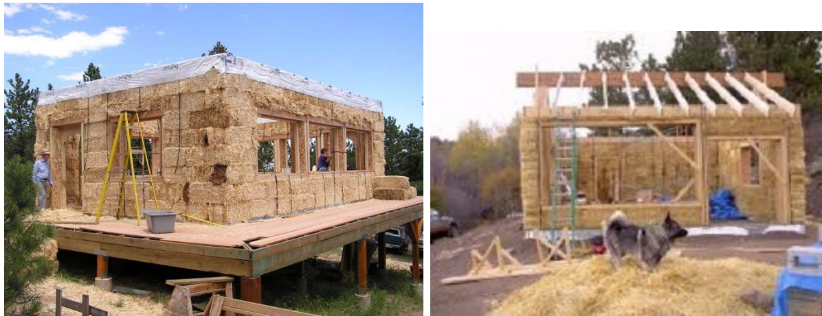
شكل (3-8) نموذج منزل مبنى من بالات القش
