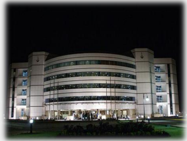
صوره رقم 5 توضح واجهات المبنى
