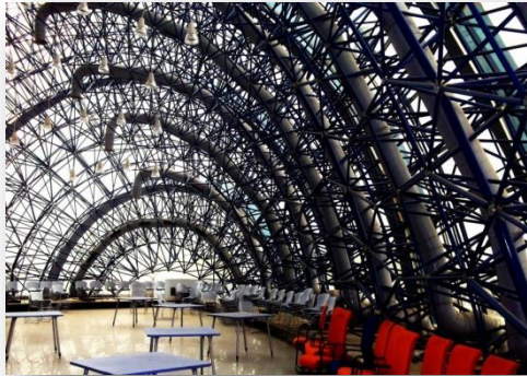
صورة (7-2) توضح النظام الإنشائي لبرج الاتصالات
