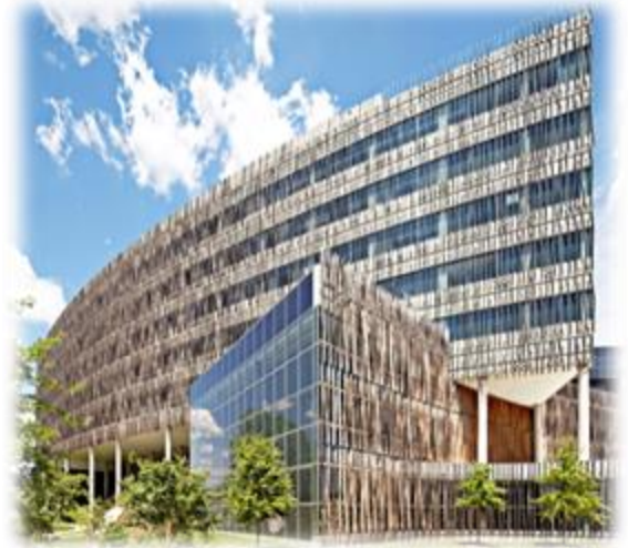
صورة (21-2) توضح منظر خارجي للمبنى
