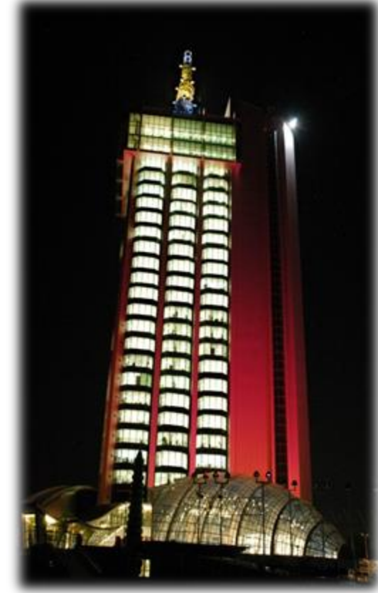
صورة (2-3) توضح الاضاءة الليلية للبرج للاتصالات
