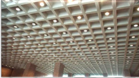
صورة رقم (87): Waffle Slab
