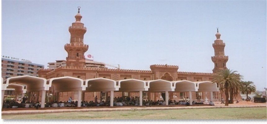
شكل (٨-٦٣) التنافر المعماري بين المظلات التي شُيدت وبين مبنى المسجد
