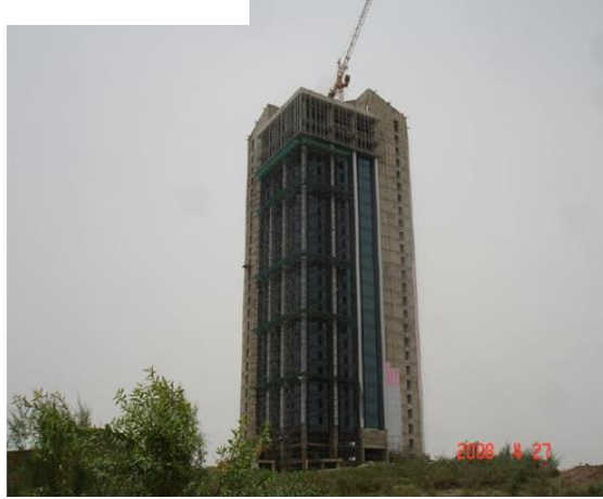
صورة ( 5-28) منظر خارجي اثناء التشييد- برج الاتصالات
