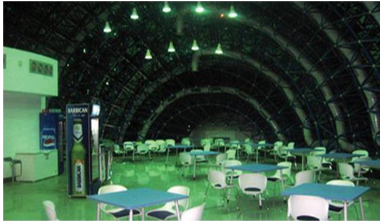
صورة ( 29-5) جزء من شكل الانشاء الداخلى - برج الاتصالات
