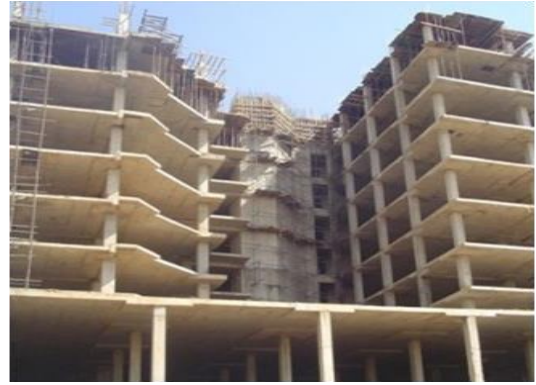
صورة ( 30-5) واحة الخرطوم - أثناء وبعد التشييد
