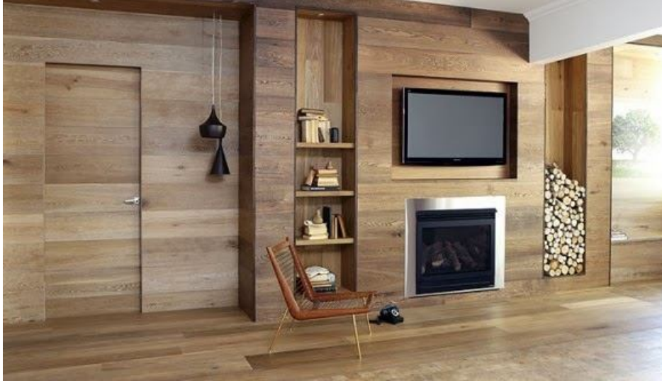
الصورة رقم (148) تبين استخدام الأخشاب المصنعة في تغليف الجدران
