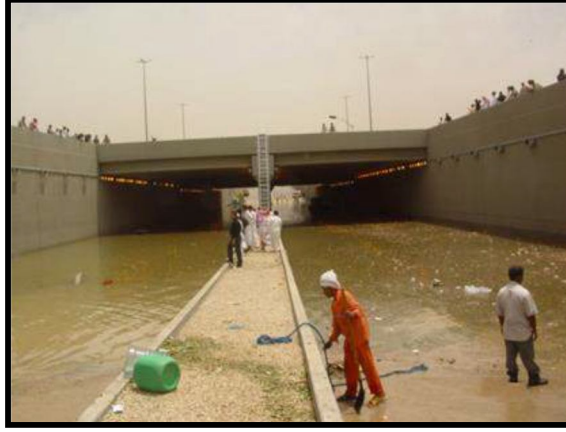
شكل (3-8) عدم القدرة على تصريف مياه الأمطار
