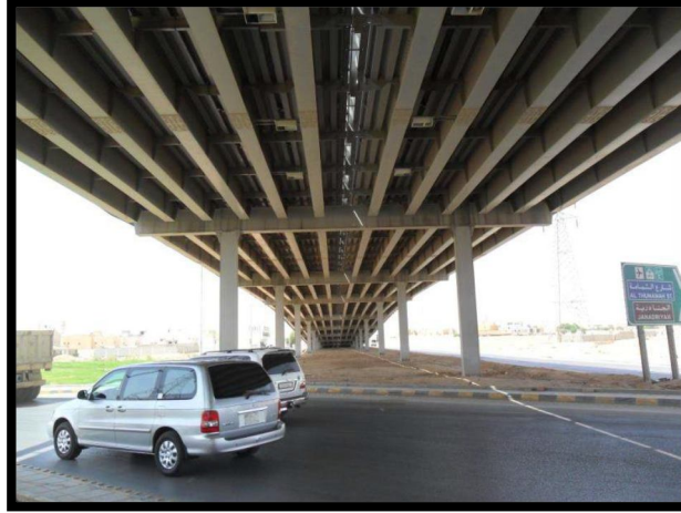
شكل (2-8) يوضح جسور كمرية من الفولاذ ، المصدر : الانترنت - دليل صيانة الجسور والأنفاق .
