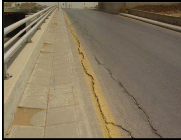
شكل (3-9) هبوط في الطبقة الأسفلتية بمحاذاة الجدار الاستنادي
